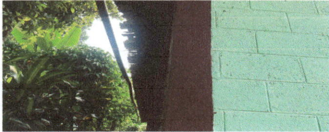
Foto1. Sustitución de lámina
