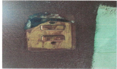
Foto 4 sustitucion de interruptores
