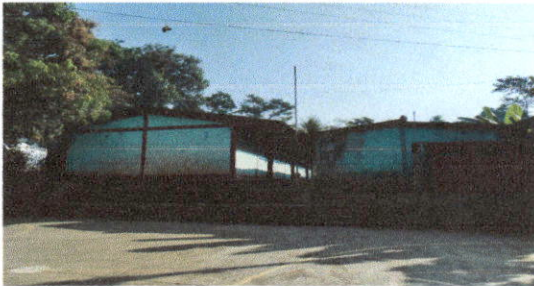
Foto3 sustitucion de láminas
