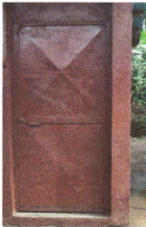
Foto 5 Sustitución de puertas
