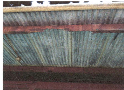
Foto 6 Sustitución de costaneras
