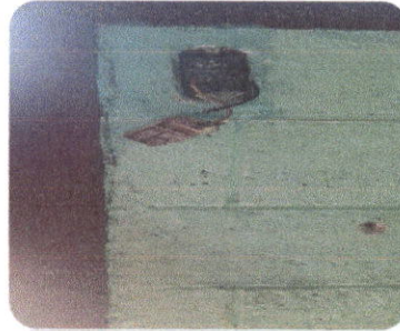
Foto 2: Sustitución de toma corriente
